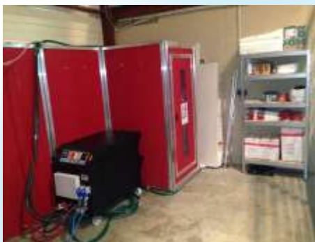
SAS 5 Salles Rouge / Contrôleur dépression et système filtration / Unité de chauffage et de filtration
