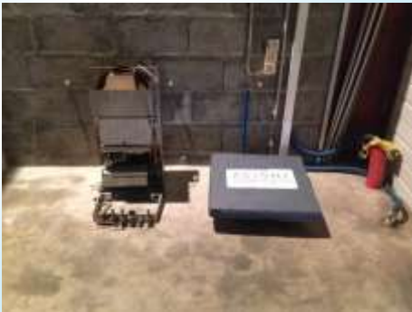
Ateliers chaudière – Perçage Carottage
