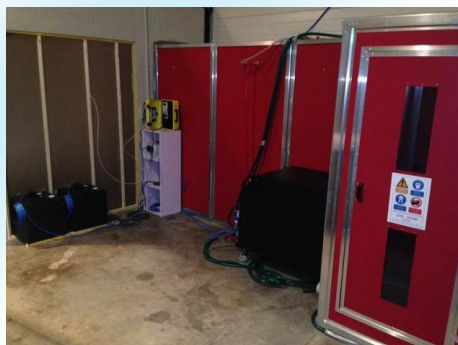
SAS 5 Salles Rouge / Contrôleur dépression et système filtration / Unité de chauffage et de filtration
