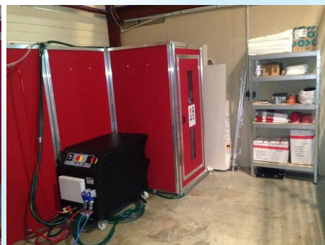
SAS 5 Salles Rouge / Contrôleur dépression et système filtration / Unité de chauffage et de filtration
